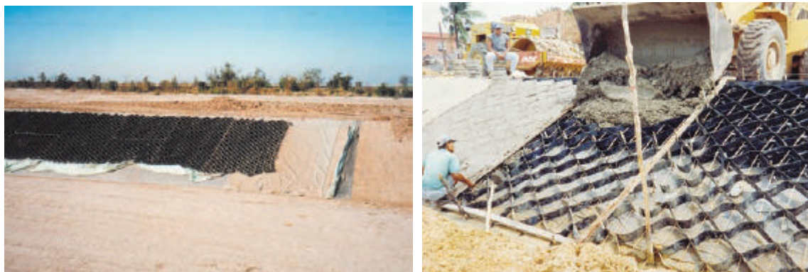
Imágenes 2.2 y 2.3 Revestimiento de taludes con geoceldas.
